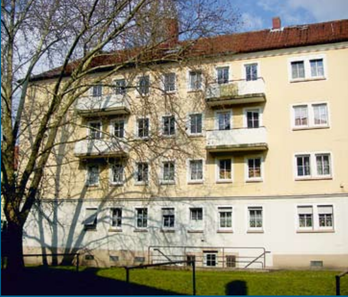
Das Gebäude Thomasstraße 50 in Worms vor Beginn der Umbaumaßnahmen
