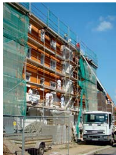
Während der Umbauarbeiten
