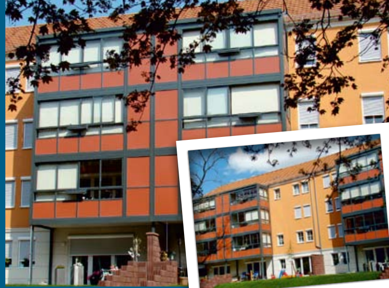
Das Gebäude Thomasstraße 50 nach Beendigung der Umbaumaßnahmen
