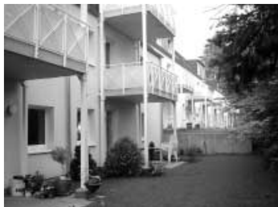
nachher: „Wohnen mit Wohlgefühl“ im 1. BA Quelle: ThyssenKrupp Immobilien
